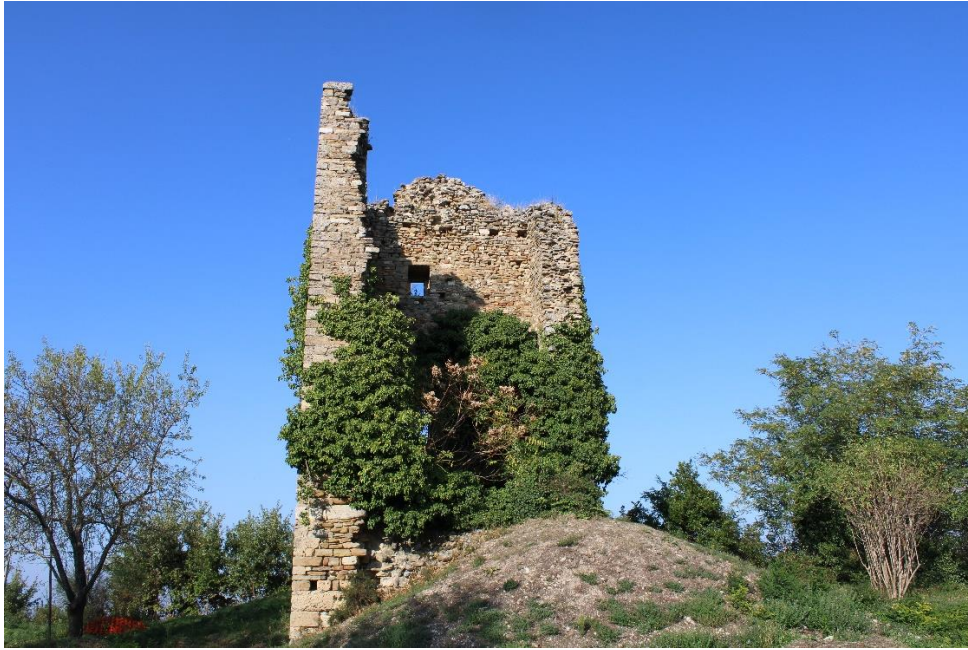
Figg. 6-7 La torre di Castelnuovo.
