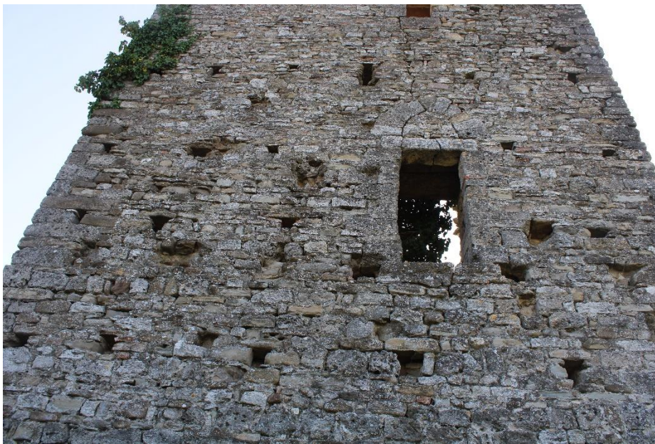
Fig. 9 Particolare della finestra della torre. Si notino i blocchi trapezoidali che costituiscono l'arco che sormonta l'architrave.
