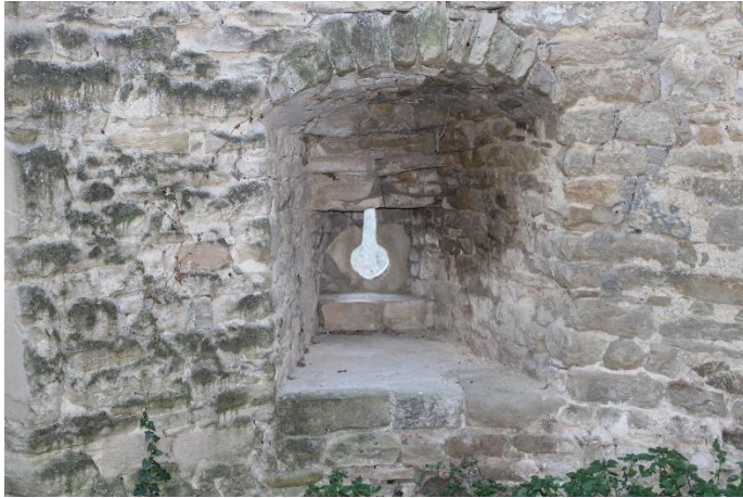
Fig. 26 Apertura a serratura rovesciata nel torrione semicircolare.
